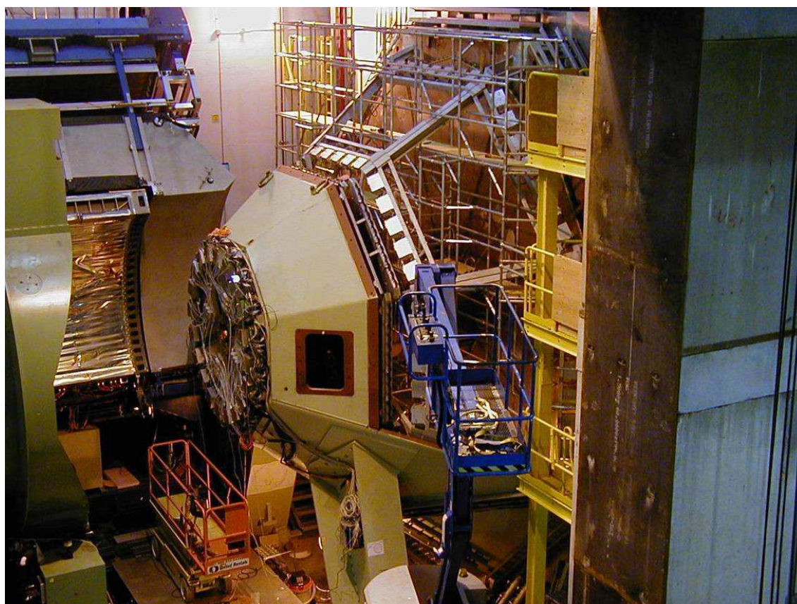
FIG. II.10 – Figure du haut : Coupe longitudinale des bras muons de PHENIX, les dimensions sont exprimées en mm. Figure du bas : Photographie du bras nord lors de l'installation des cartes d'électronique.
